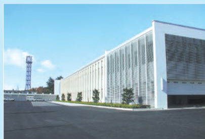
六ヶ所保障措置センター
