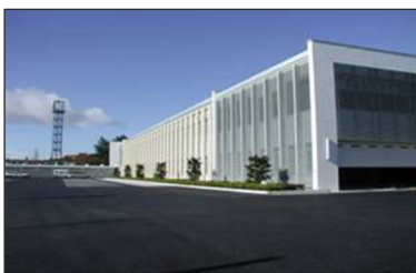
六ヶ所保障措置センター
