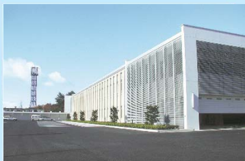
六ヶ所保障措置センター
